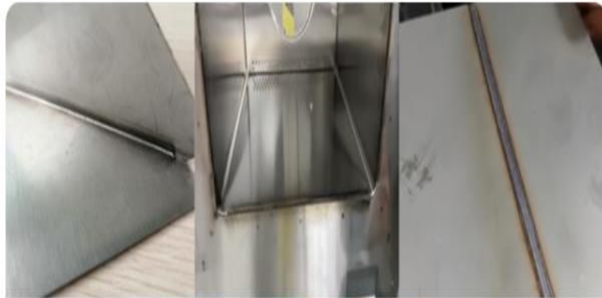
焊缝美观、无疤痕、工件无变形
